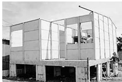
que tienen un canal donde se insertan las baldosas, estas se colocan una junto a la otra y forman paredes más delgadas que las de block.
