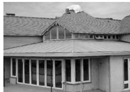
**Fibrocemento (Fibrolit, Ricalit):** es un material hecho a base de una mezcla de cemento, comprimido en láminas de diversos tamaños y formas. Generalmente lo encontrará en forma de teja o en láminas onduladas. Es del mismo material del FIBROLIT o PANELEX pero de menor grosor. Además se incluye aquí el denominado asbesto-cemento (Ricalit).
