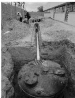
**Conectado a tanque séptico común:** es una solución individual en la que el servicio sanitario se comunica con un tanque de concreto o cemento armado, conectado a vías de drenaje. Por lo general, está construido en el patio de la casa.
