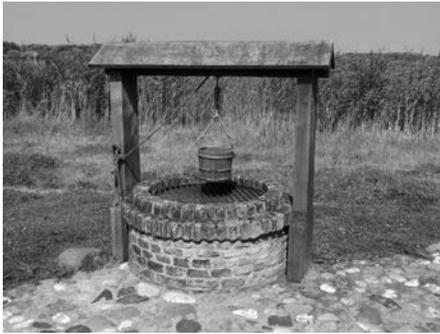
**Pozo:** puede ser propio o comunitario. Del pozo se extrae agua subterránea mediante el empleo de una bomba eléctrica o manual, o bien utilizando un recipiente, atado al extremo de una cuerda.
