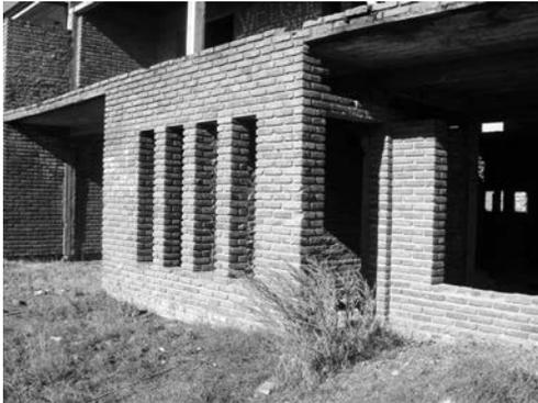
**Block o ladrillo:** comprende todos aquellos materiales cementados y repellados como el ladrillo, el block, concreto chorreado, piedra, etc. No incluye paredes prefabricadas.
