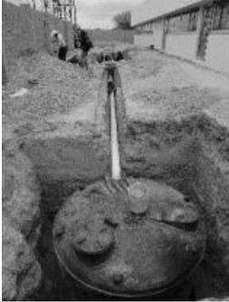
**Conectado a tanque séptico común:** es una solución individual en la que el servicio sanitario se comunica con un tanque de concreto o cemento armado, conectado a vías de drenaje. Por lo general, está construido en el patio de la casa.
