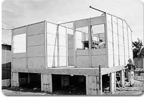
**Prefabricado:** corresponde a las baldosas de concreto que se adquieren ya fabricadas y que juntas conforman las paredes. Son sostenidas por postes o columnas que tienen un canal donde se insertan las baldosas, estas se colocan una junto a la otra y forman paredes más delgadas que las de block.
