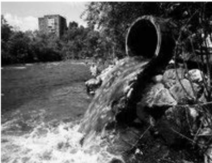
**Con otro sistema:** servicios sanitarios conformados por una “taza” o algún objeto que desagua en una corriente natural de agua: acequia, zanja, río, estero, etc.
